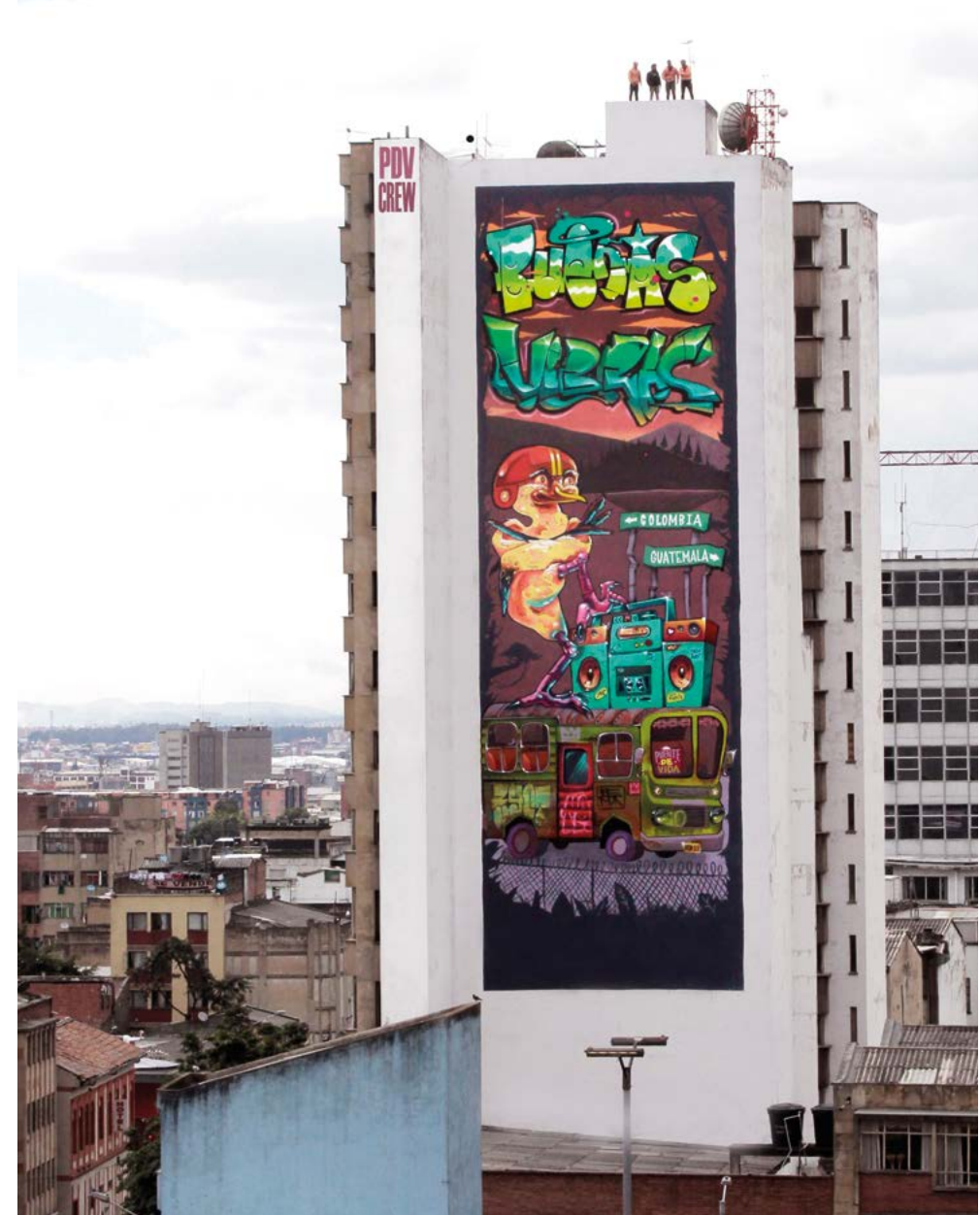
Tripulantes PDV Crew Barrio Las Lomas Calle 22 Sur con carrera 12
